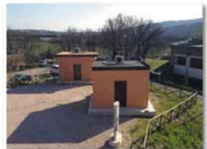
Misurazioni e test monitorati nell'anno solare su un prototipo di casa privo di isolamento per la prestazione energetica dell'edificio.
